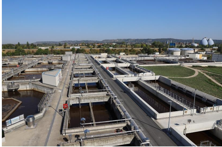
Erweiterung Belebungsanlage, 2. Bauabschnitt
